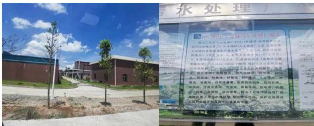
图1.5-5 鹤山工业城鹤城共和片区污水处理厂现场照片
