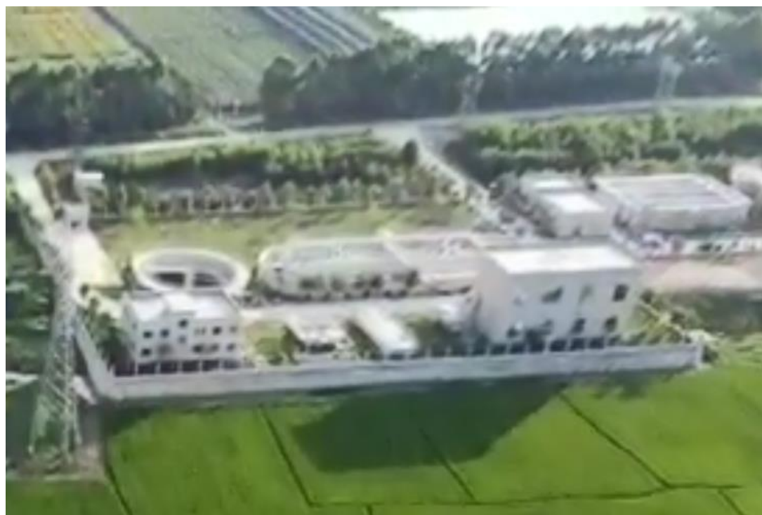
图 1.5-7 址山园污水处理厂航拍照片
