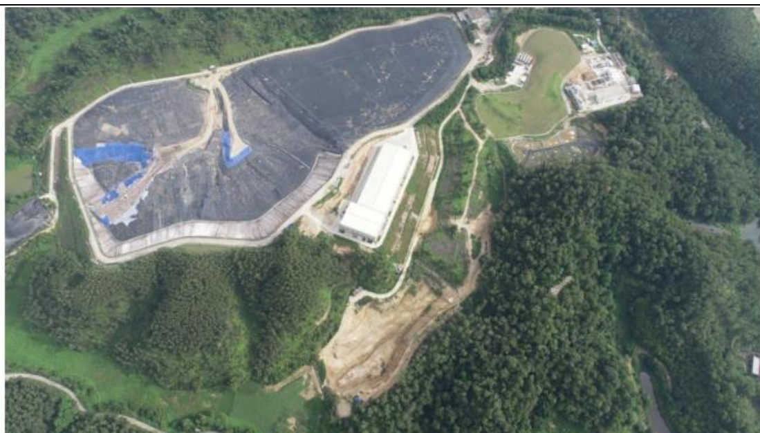
垃圾填埋场现场照片
