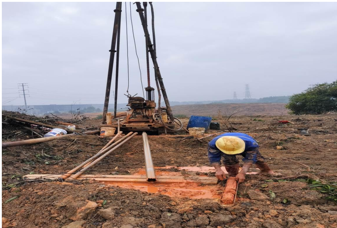
照片 2 ZK2 地块现状
