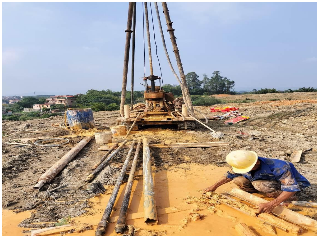
照片 4 ZK4 地块现状
