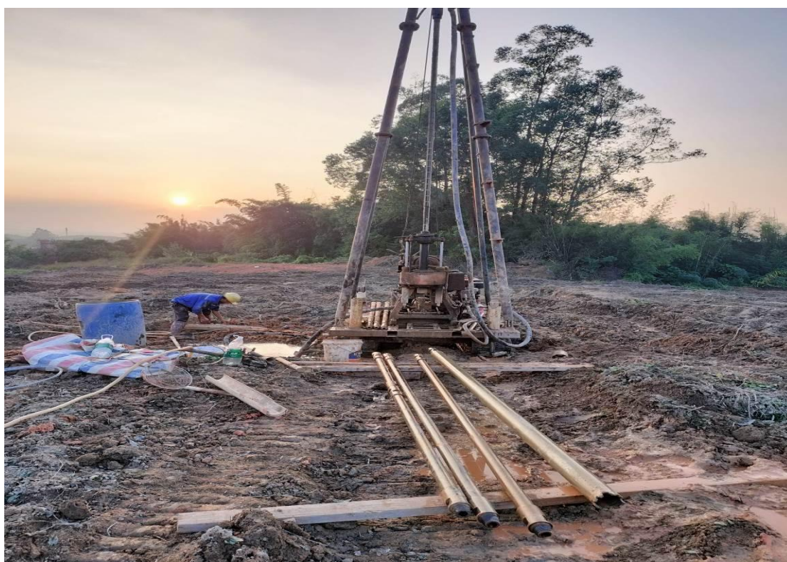
照片 1 ZK1 地块现状
