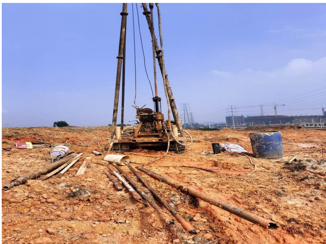
照片 3 ZK3 地块现状
