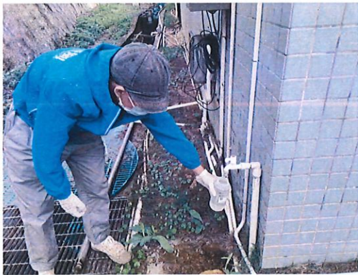
四堡水库采样口
