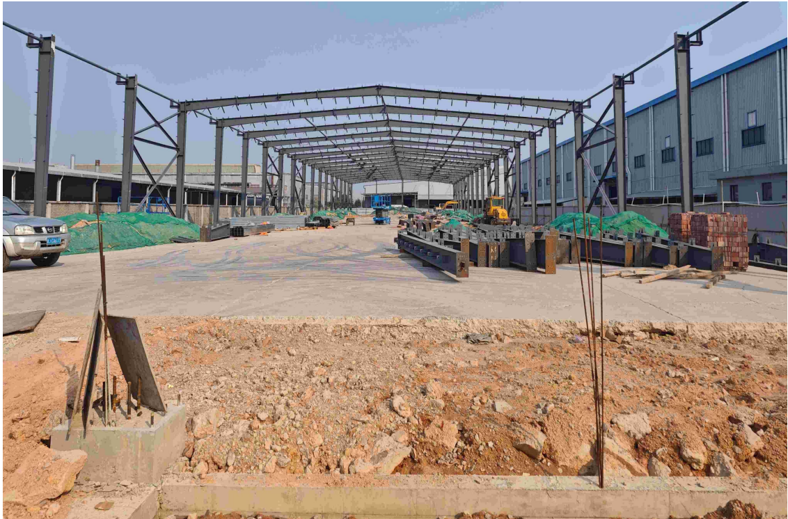
图 1 德顺公司厂房二项目现场
