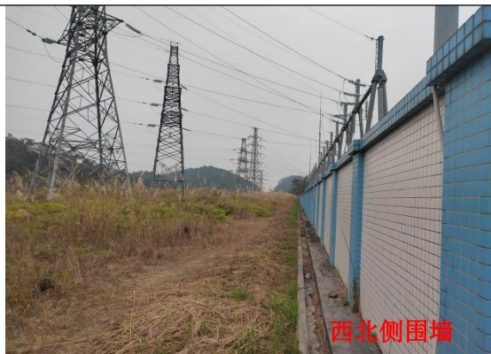
变电站西北侧
