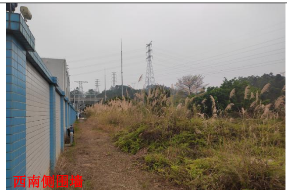
变电站西南侧
